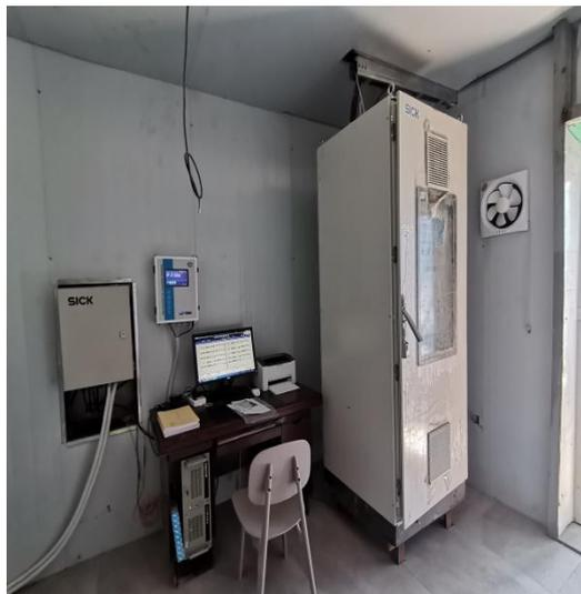
图 2-2 烟气监测系统安装点位
