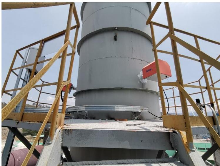
图 2-3 烟气采样点安装点位
